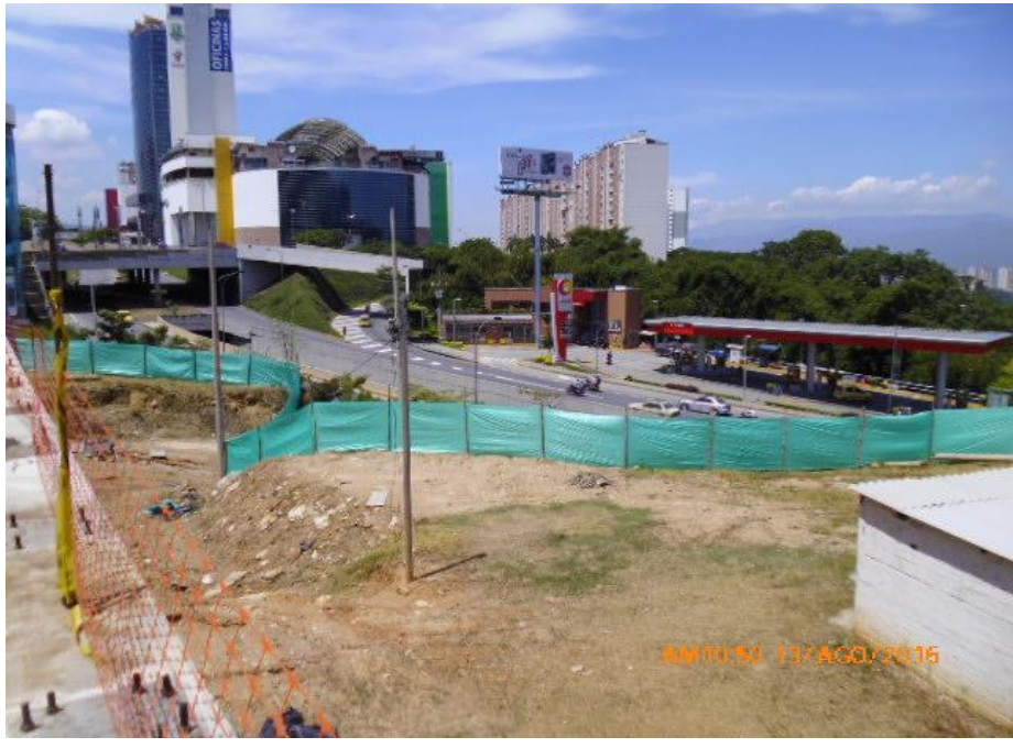
Rocería, instalación de cerramiento costado occid , instalación de teja-adecuación del campamento
